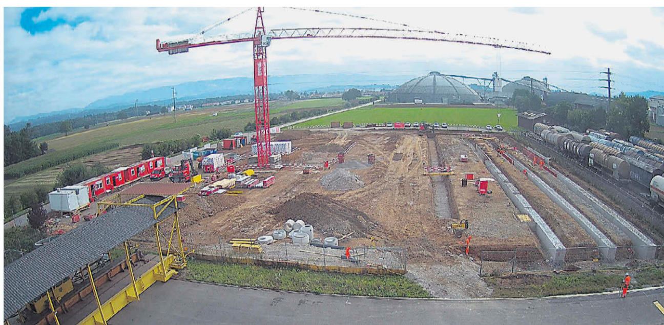
Grosse Baustelle: Auf rund 5000 Quadratmetern entsteht das neue Logistikzentrum der Swisslos.
